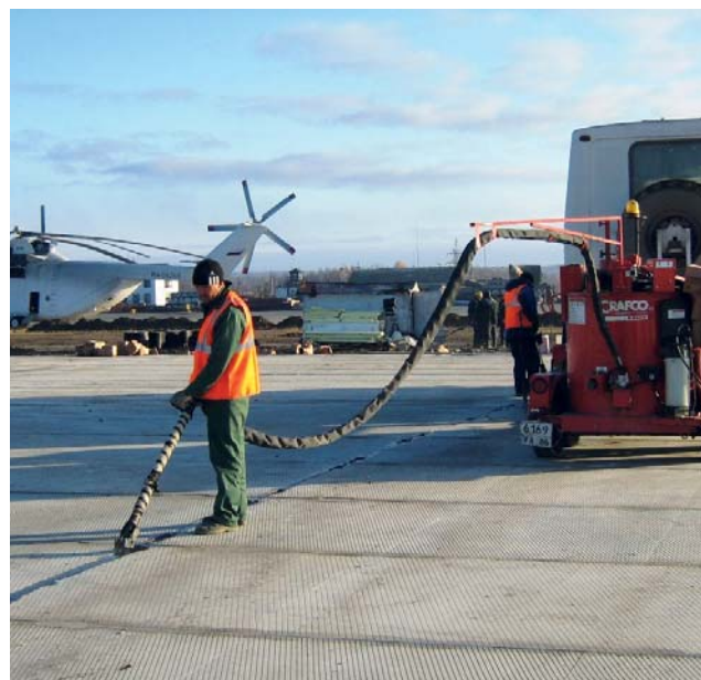
Компрессор используется только для подключения теплового копья и дополнительного оборудования
