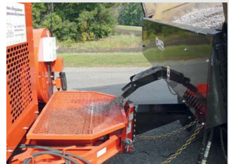
Подача каменного материала Гидравлическими шнеками
