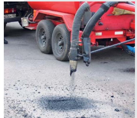
Производительность до 60 кг. готовой смеси в минуту
